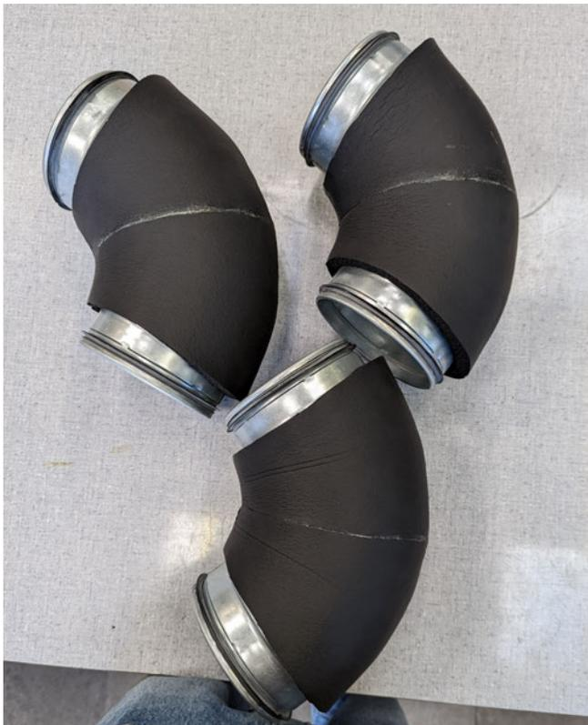
Abbildung 4.3: Wärmegedämmte Rohrkrümmer mit Armaflex®-Mantel.
