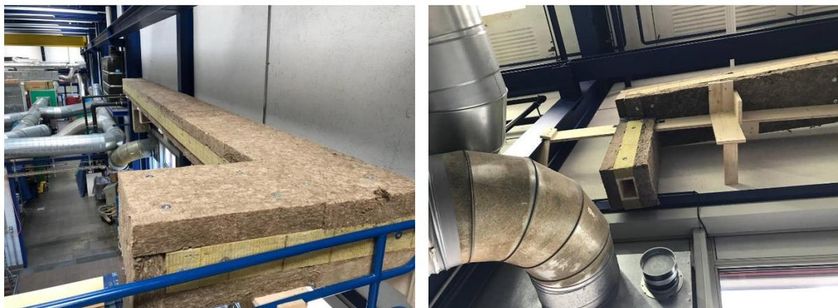
Abbildung 8: Fortluft- und Aussenluftleitung, Grundaufbau
