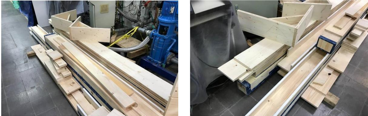
Abbildung 10: Massivholzplatten für Grundaufbau
