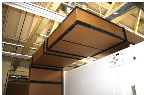
Abbildung 32: Beispiele GatorDuct<sup>®</sup> Karton-Leitungen (GatorDuct, 2022)
